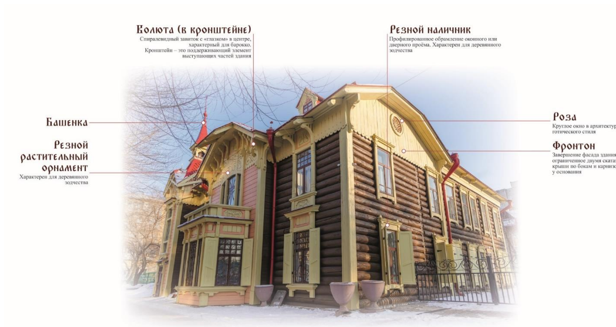
Рисунок 15 – Архитектурные и декоративные элементы здания
