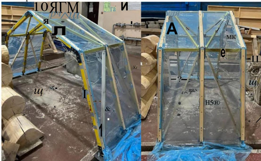
Рисунок 108 - Покрытие конструкции пленкой Р-40
