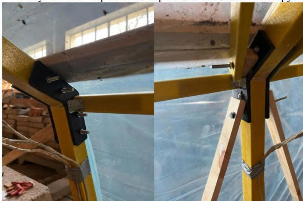
Рисунок 107 – Способы крепления связей к узлам
