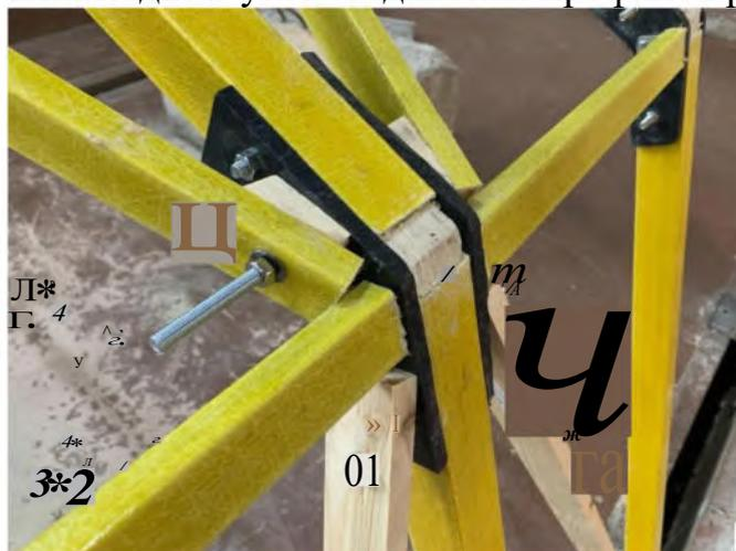
Рисунок 105 - Узел крепления связей
