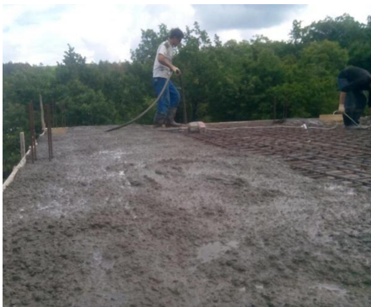
Рис. 4.3 – Бетонирование монолитной плиты
