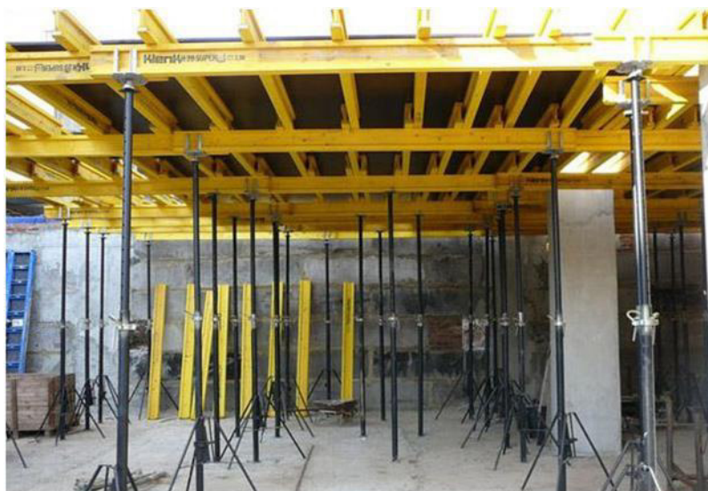
Рис. 4.1 – Устройство опалубки
