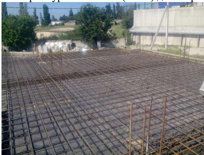
Рис. 4.2 – Армирование монолитной плиты
