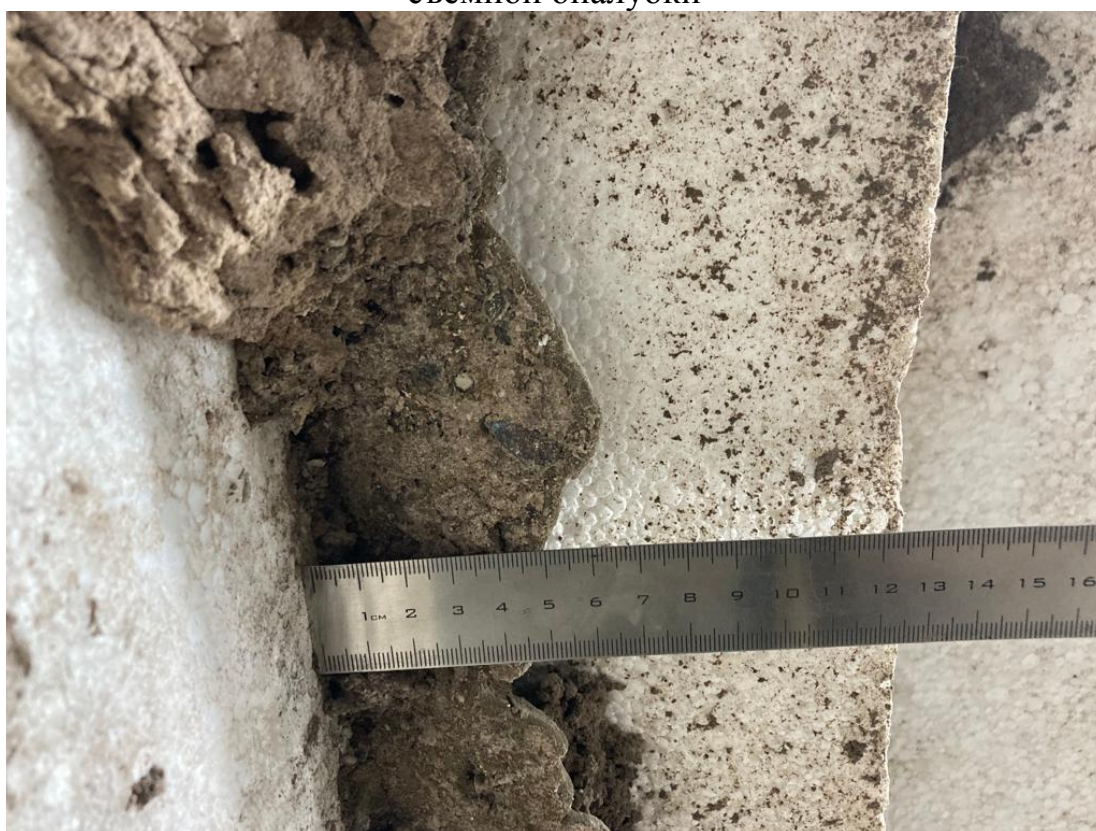
Рисунок 3.2.7 – Утепление фундаментной стены - Вариант возведения фундаментной стены с разработкой котлована больших размеров с использованием разборной опалубки.
