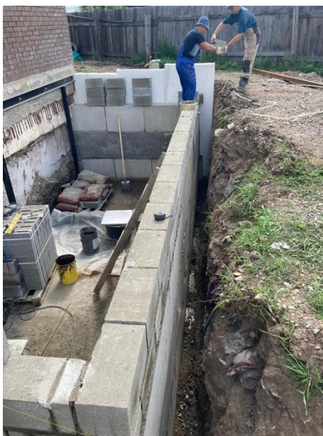
Рисунок 1.4.3 – Возведение подземной части пристройки лаборатории
