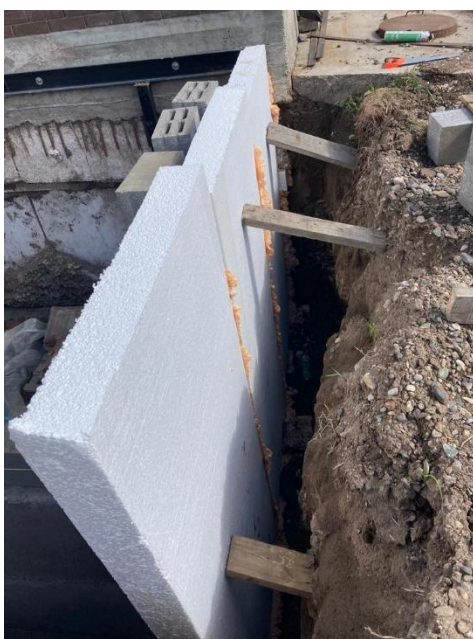
Рисунок 1.4.2 – Теплозащита пристройки лаборатории с юго-запада
