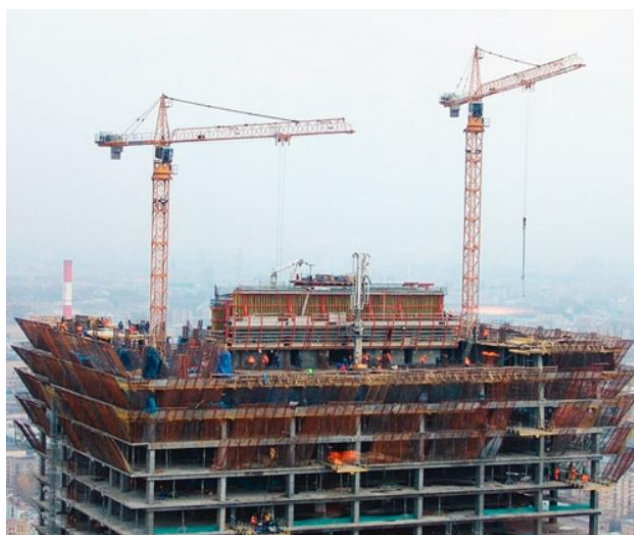
Рисунок 4.1 – Самоподъемный кран УБК 5-95
