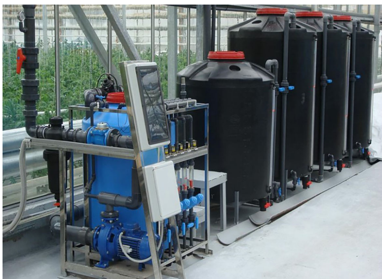
Рис. 1. Внешний вид установки для орошения сельскохозяйственных культур
