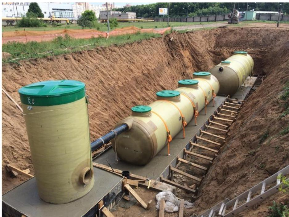
Рисунок 4.2 – Установка локального очистного сооружения
