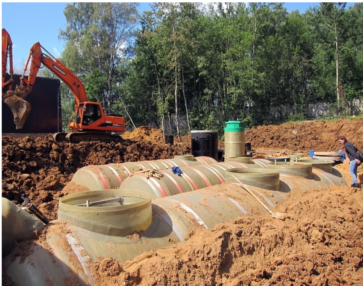
Рисунок 4.2 – Установка локального очистного сооружения
