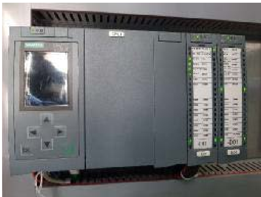
Рисунок 10.19 – Общий вид контроллеров программируемых SIMATIC S7-1500
