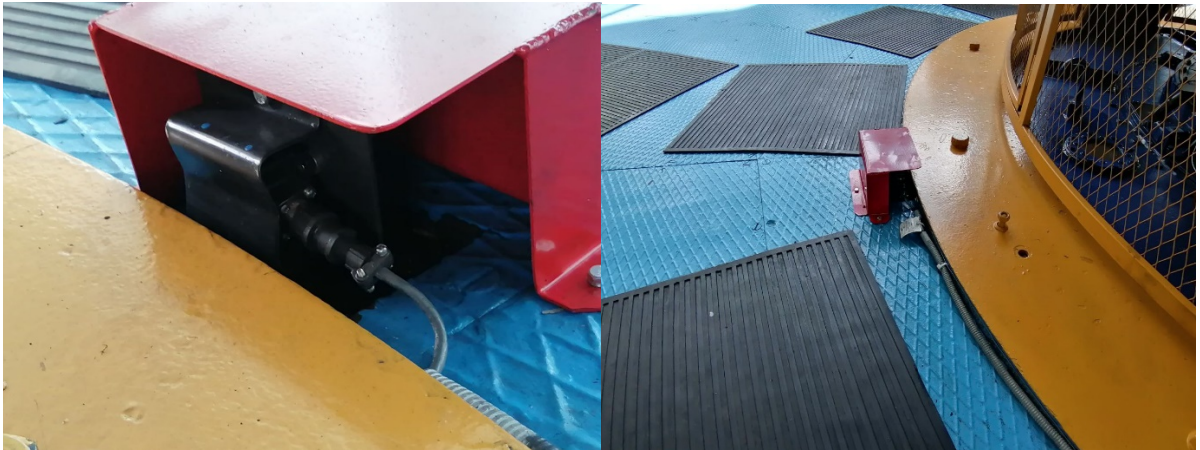
Рисунок 10.13 – Датчик радиальной вибрации корпуса генераторного подшипника
