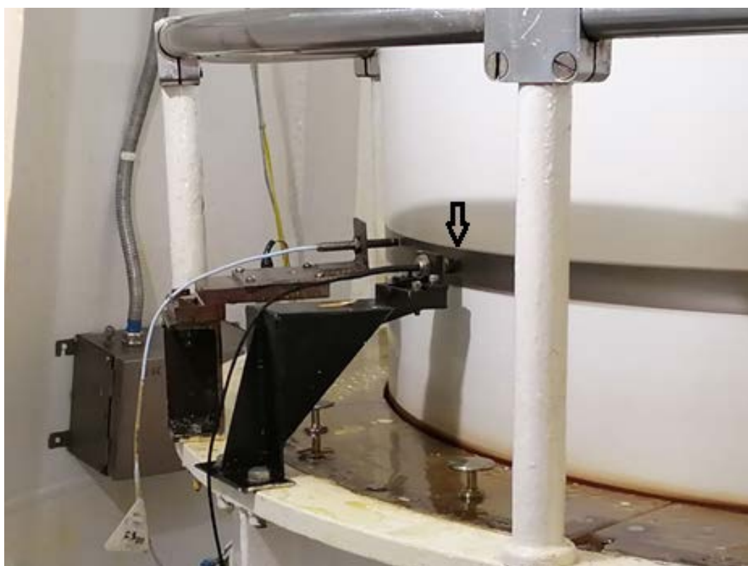
Рисунок 10.18 – Датчик боя вала в районе турбинного подшипника
