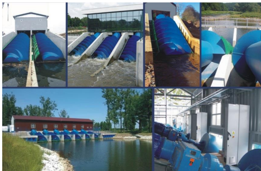
Рисунок 10.1 – Малая ГЭС с вихревой гидротурбиной
