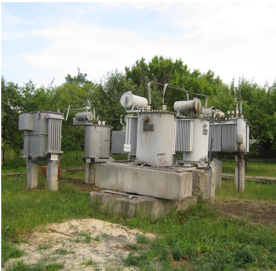
Рисунок 2- Дугогасящий реактор
