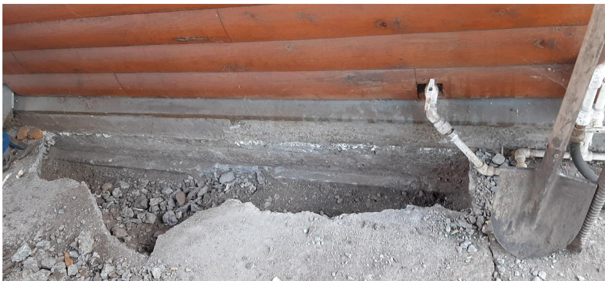
Рисунок 3.1 – фрагмент стены технического подвала перед утеплением
