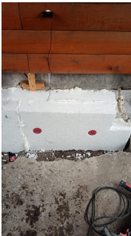
Рисунок 3.2 – фрагмент утепления стены технического подвала
