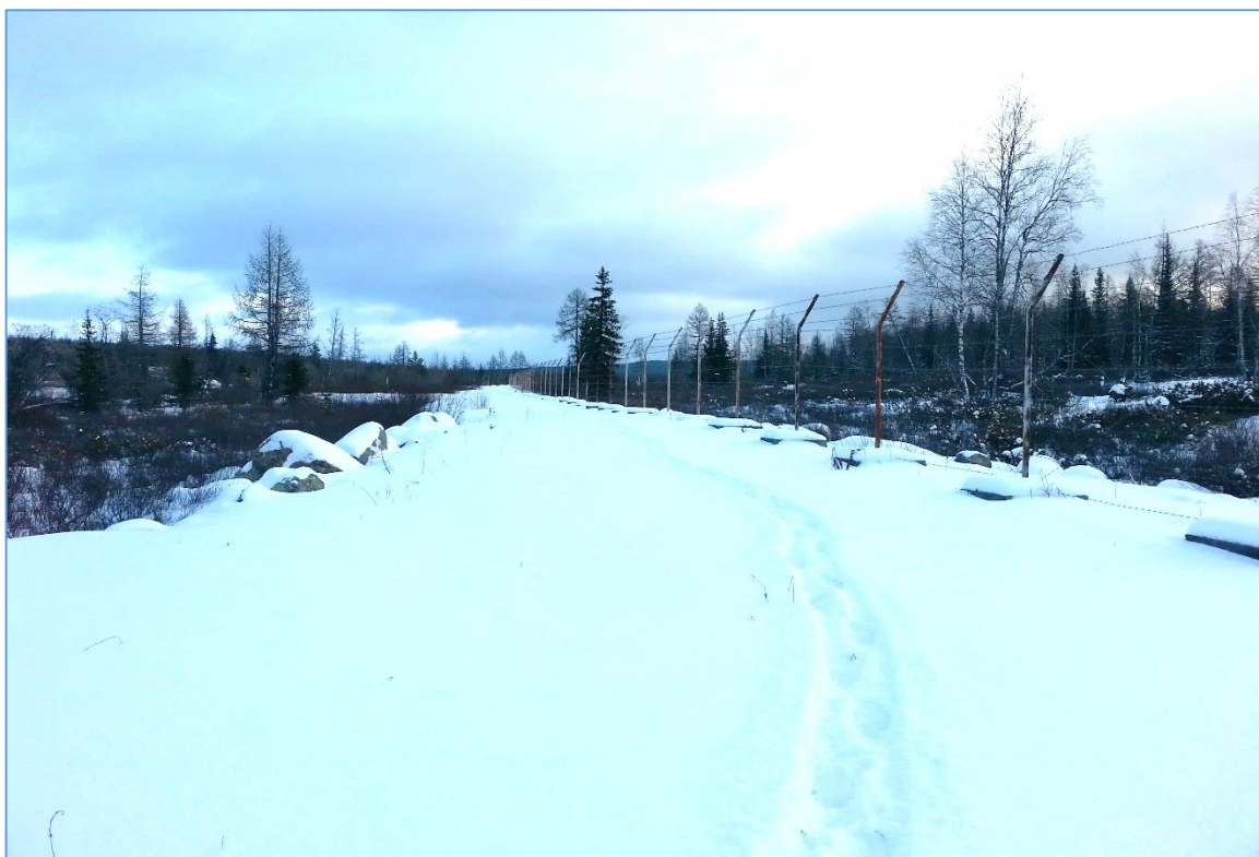
Рисунок 1.3 – Вид на ограждение водозабора Широкинского
