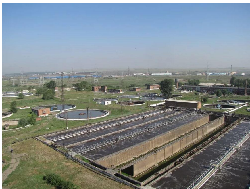
Рисунок 1.2 – Панорама цеха левобережных очистных сооружений
