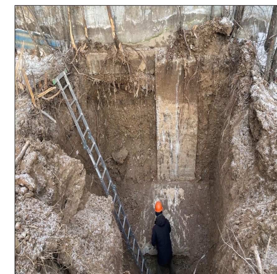
Общий вид фундамента под колонну в осях 39–Н.
