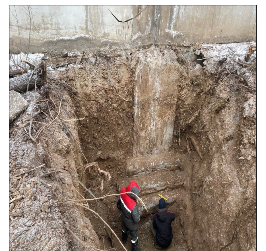
Общий вид фундамента под колонну в осях 37–Н.
