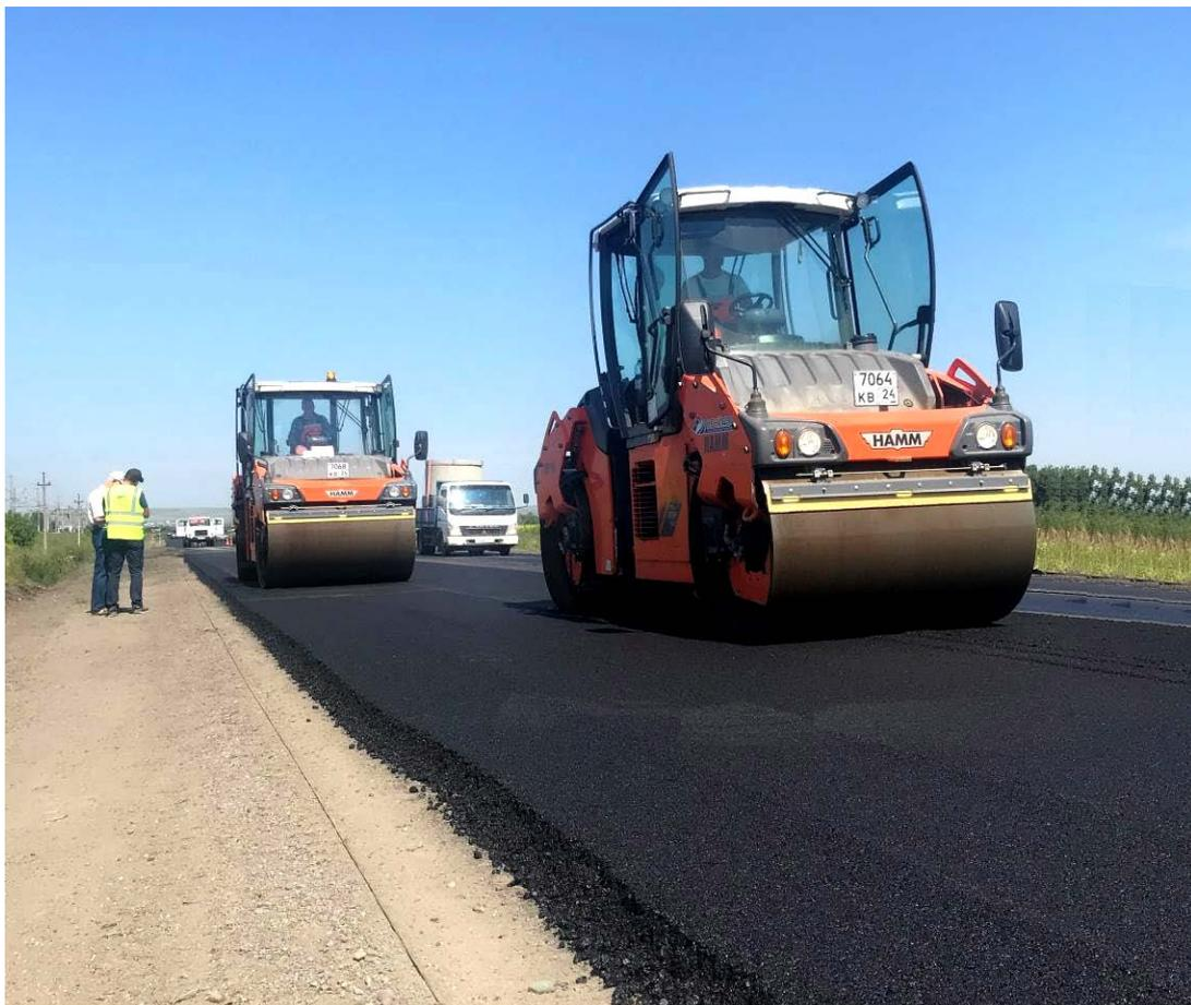
Рисунок 3.14 – Укатка асфальтобетона вибрационным катком
