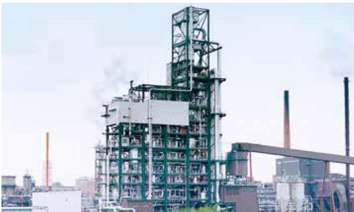
Рисунок 3 – Установка газификации торфа на производстве аммиака в Финляндии мощностью 300 т/сутки
