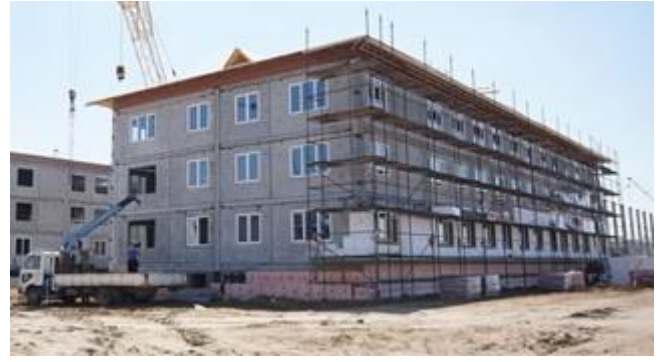
(г) железобетонные стеновые панели
