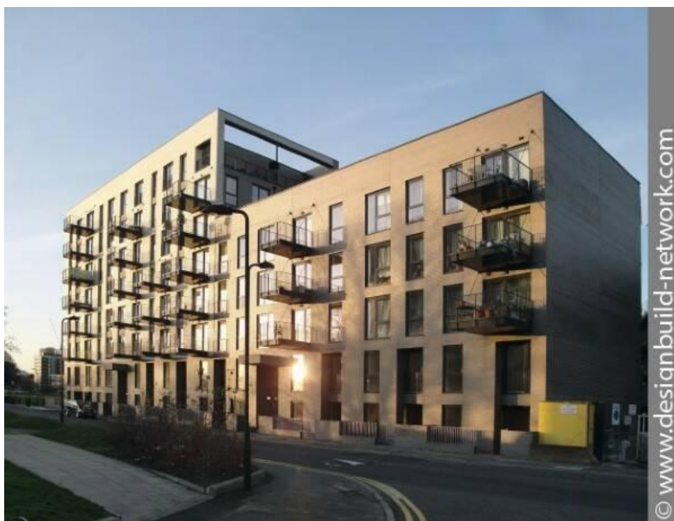
Рисунок 2.1.4 – Дом из CLT-панелей Bridport House в г. Лондон, Великобритания.
