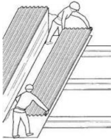
Рисунок 5.3 - Укладка стального профилированного настила
