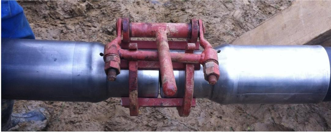
Рисунок 12 – Общий вид процесса центрирования фитингов перед сваркой.
