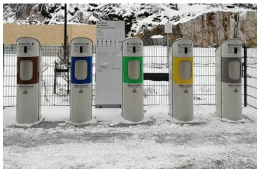
Рисунок 12 – Система вакуумных мусоропроводов, Финляндия
