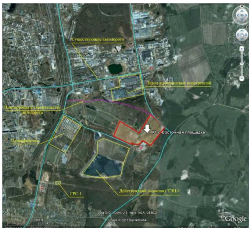
Рисунок 4 – Место строительства новой ТЭЦ
