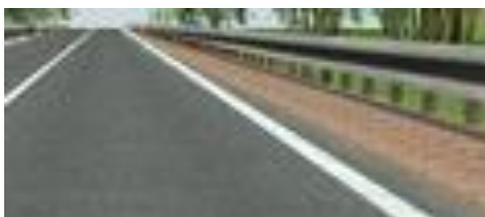
Рисунок 5.10 – Дорожная разметка 1.2 – Край проезжей части
