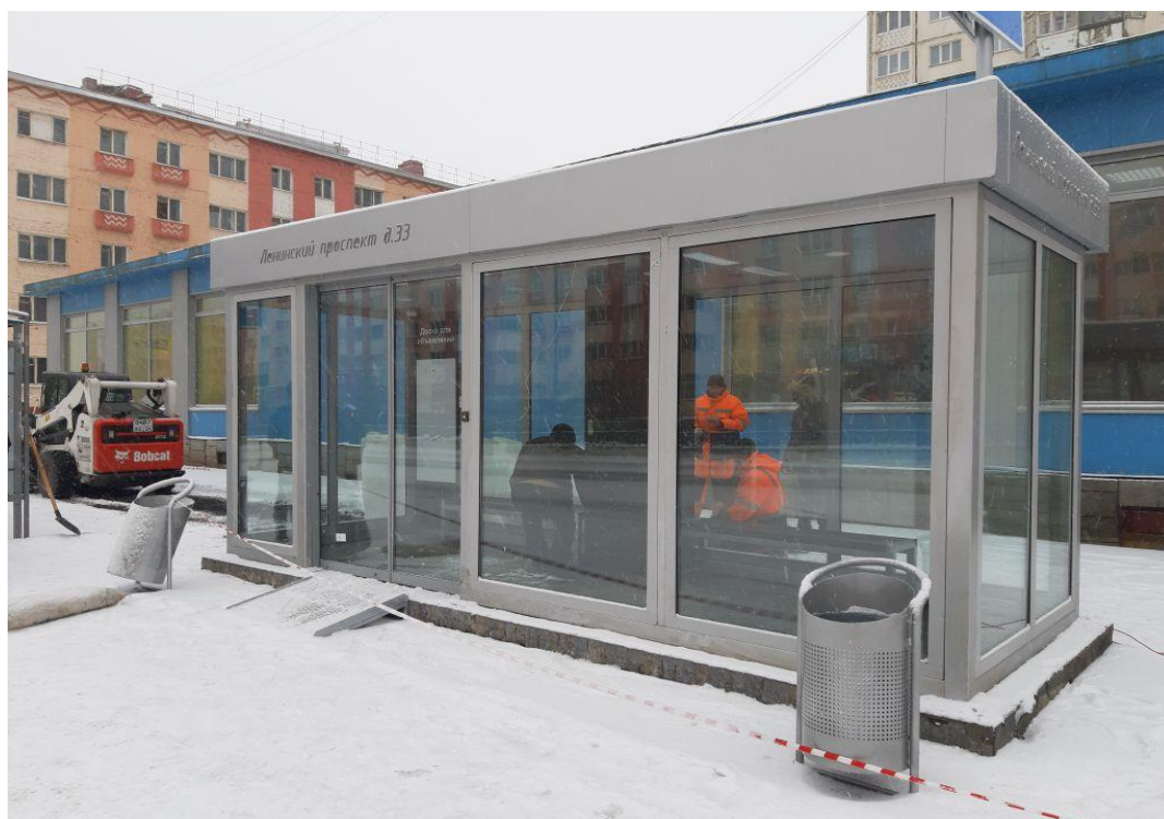
Рисунок 1.4.1.5 – Павильон теплой остановки в г. Норильск на ул. Ленинский проспект д.33
