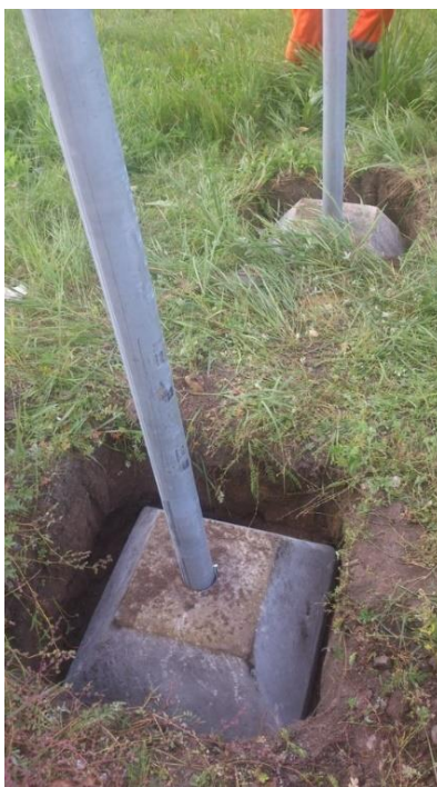
Рисунок 2.24 – Фундамент для стоек дорожных знаков
