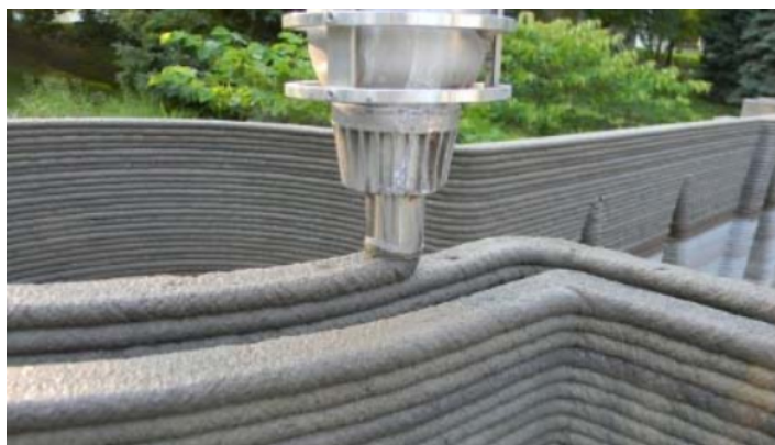
Рисунок 1.2–Процесс построения по технологии Concrete Printing
