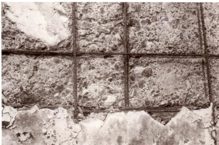
Рисунок 1.13 – Разрушение поверхностного слоя керамзитобетонной панели
