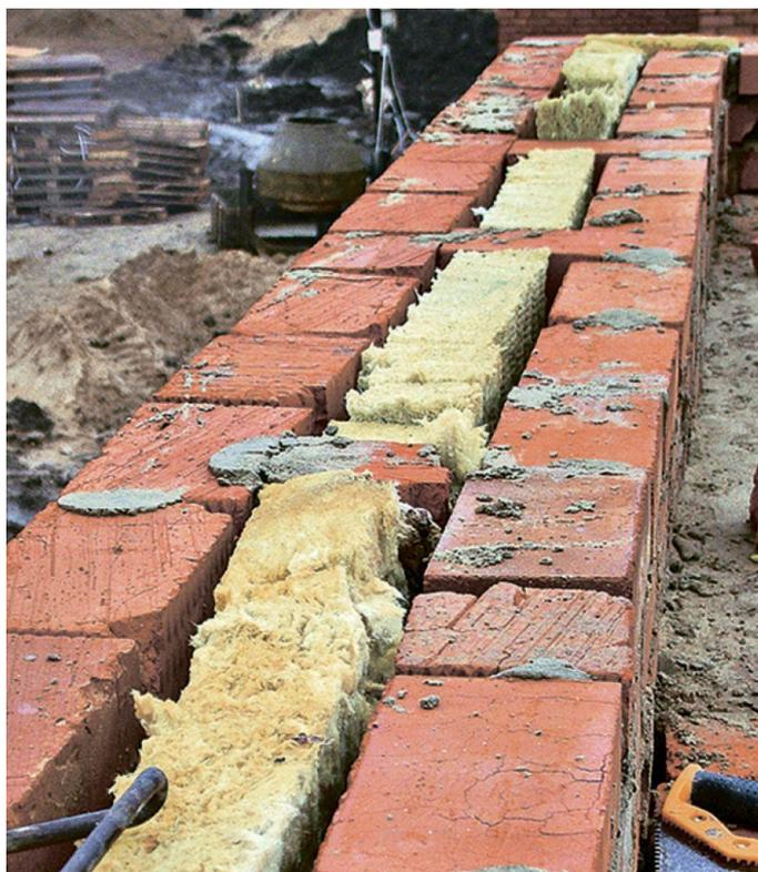
Рисунок 3.13 – Дефект в укладке утеплителя
