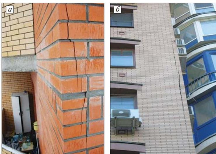
Рисунок 3.15 – Трещины в облицовке фасадов наружных стен
