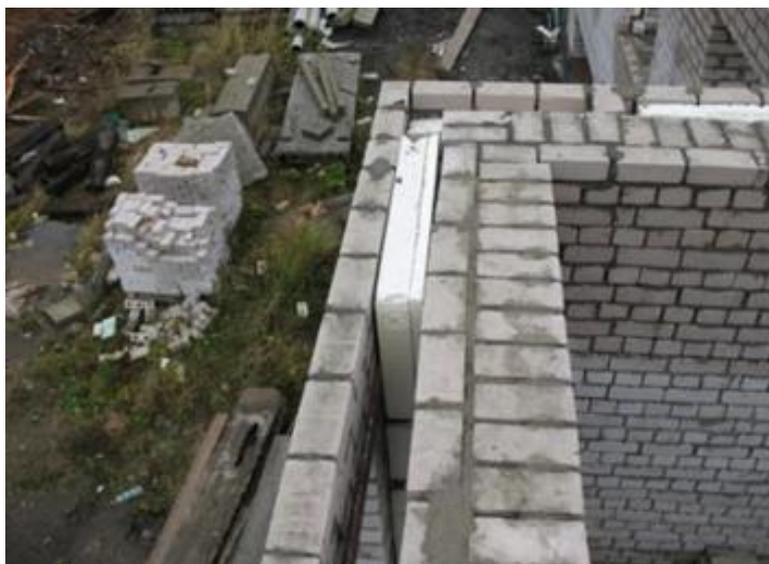
Рисунок 3.10 – Монтаж утеплителя
