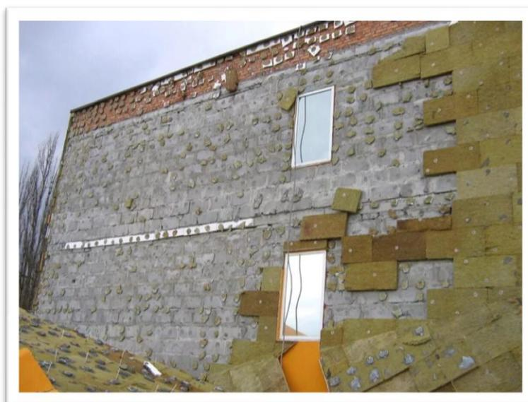
Рисунок 12 – Дефекты при монтаже теплоизоляции с оштукатуриванием по сетке
