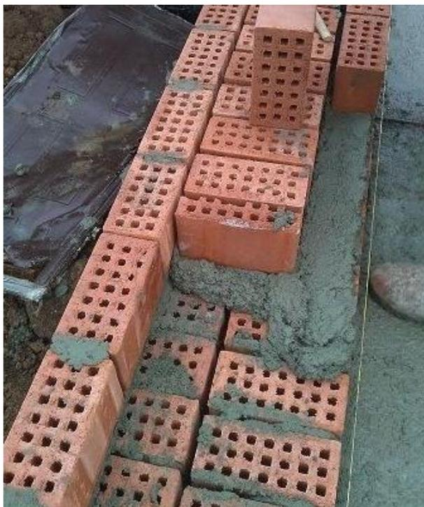
Рисунок 3.11 – Дефекты устройства штучных изделий при монтаже теплоэффективных стен
