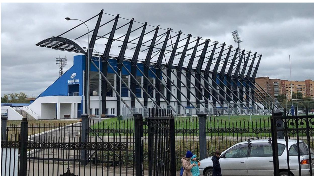
Рисунок 1.10 – Трибуна Стадиона "Авангард" в г.Красноярске, утепленная по системе "Мокрый Фасад"
