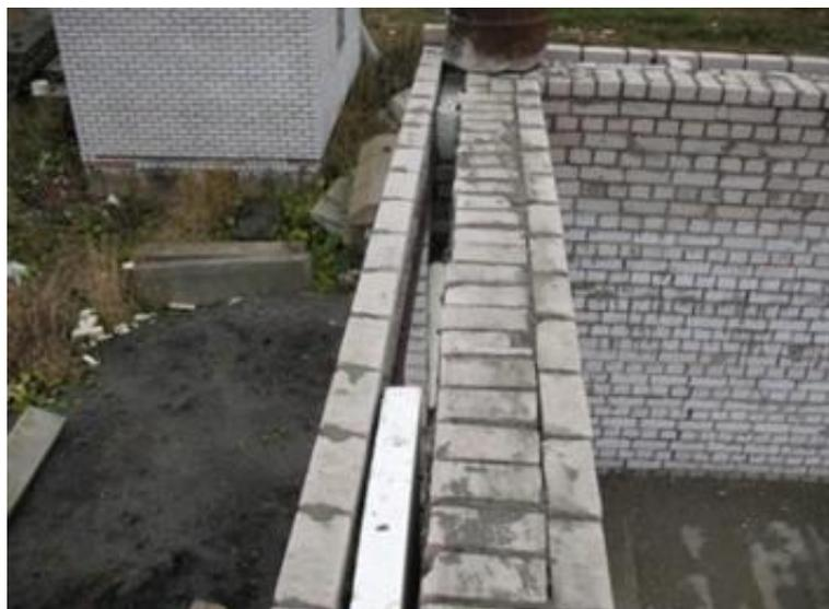
Рисунок 3.8 – Монтаж утеплителя
