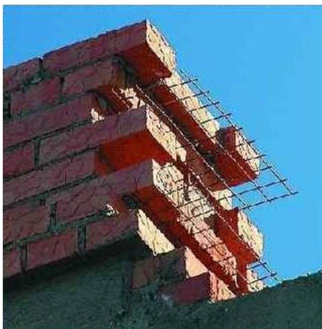
Рисунок 3.12 – Непроектное положение гибких связей
