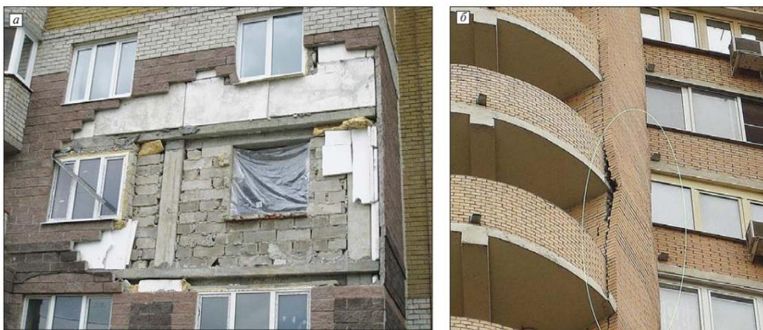
Рисунок 3.14 – Обрушение облицовочного слоя из бетонных камней и выпучивание кирпичной облицовки зданий в Московской области
