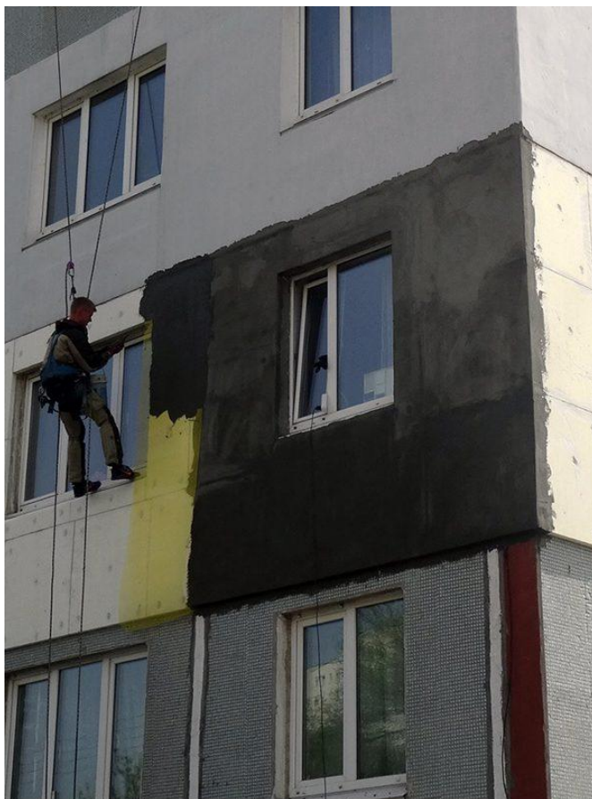
Рисунок 1.4 – Утепление стен панельного дома снаружи
