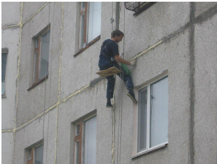
Рисунок 1.5 – Утепление швов панельного дома
