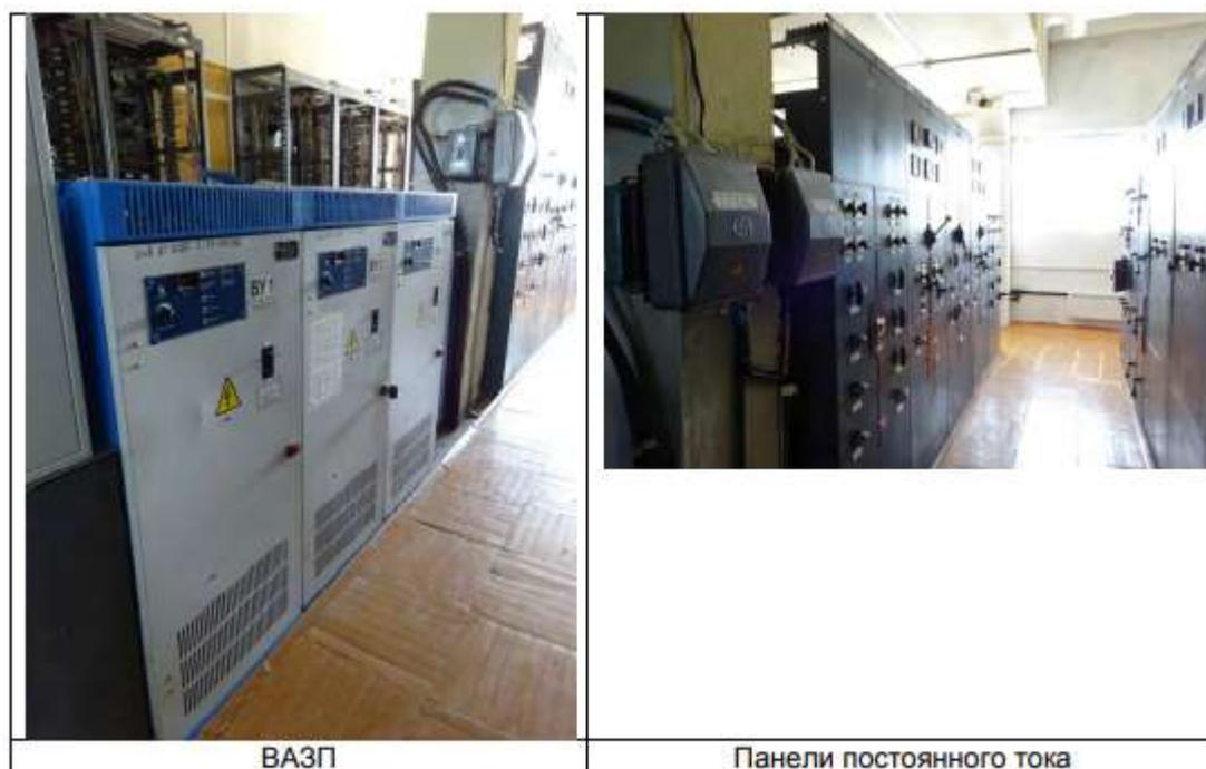
Рисунок 8.1 – Установленные на ПС ВАЗП и панели постоянного тока
