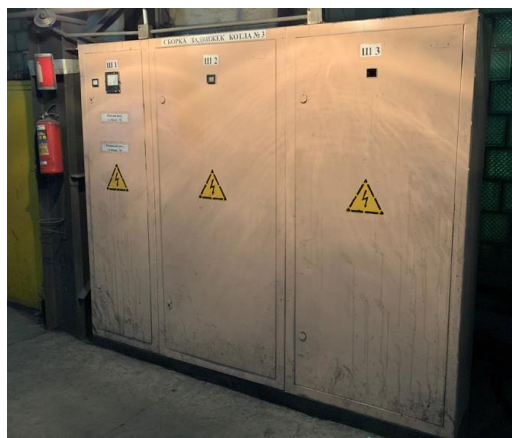
Рисунок 2.6 – Сборки задвижек котлов
