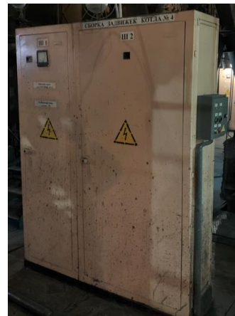
Рисунок 2.6 – Сборки задвижек котлов
