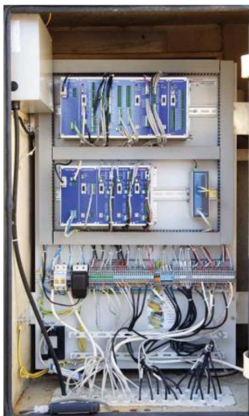
Рисунок 2 – Устройство шкафа АСМД
