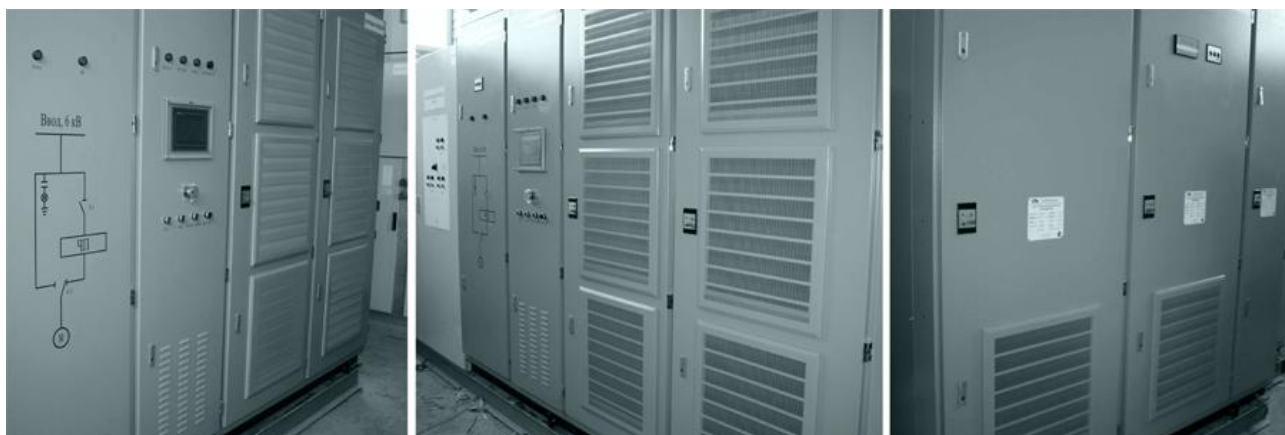
Рисунок 3.3 – ПЧ частоты СТА–В9.NVI Российской фирмы ООО«ТЭС».
