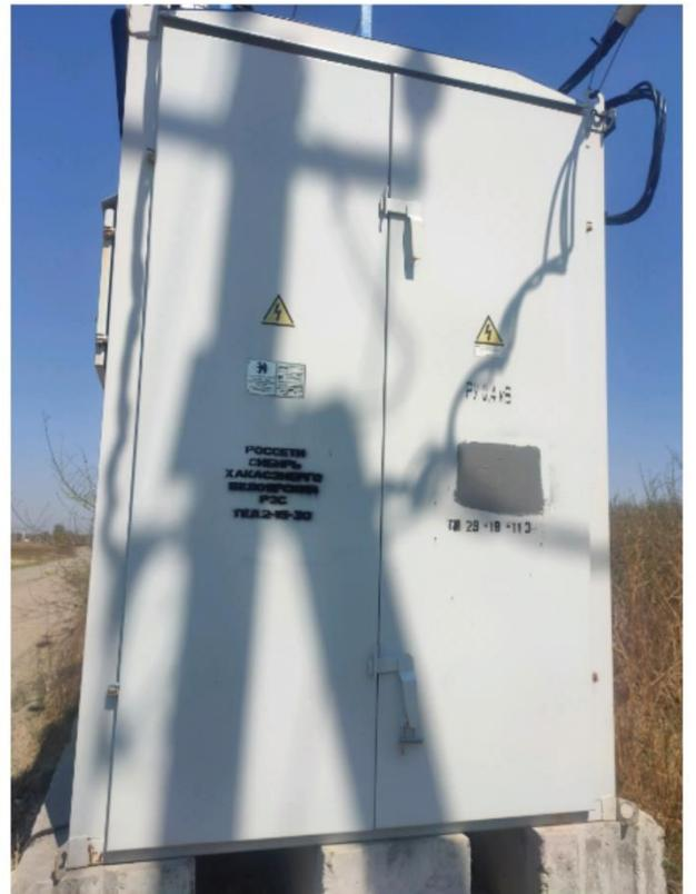
Рисунок 1.3 – Оборудование, которое можно встретить на территории массива (КТП столбового и киоскового типа)
