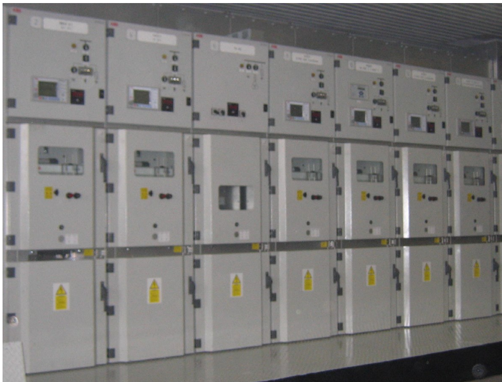
Рисунок 3 – КРУ-35кВ Unigear ZS 3.2
