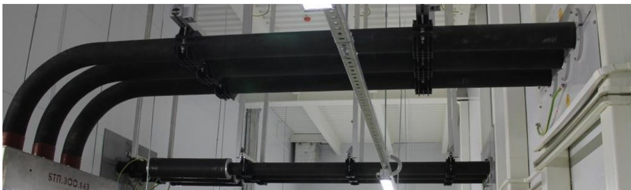
Рисунок 1 – с на напряжение 6 кВ, номинальный ток 1600 А, ток электродинамической стойкости 31 кА, климатическое исполнение и категория размещения по ГОСТ 15150 – У3
