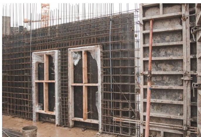
Рисунок 4.3 – Инвентарные проемообразователи
