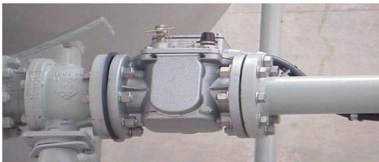
Рисунок И.5 – Газовое реле (реле Бухгольца)
