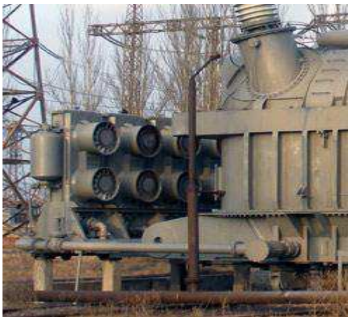
Рисунок 10.3 – Один из видов системы охлаждения силового трансформатора
