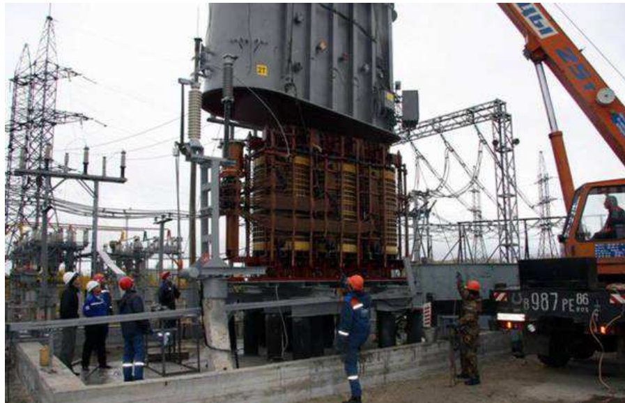
Рисунок 10.4 – Капитальный ремонт силового трансформатора
