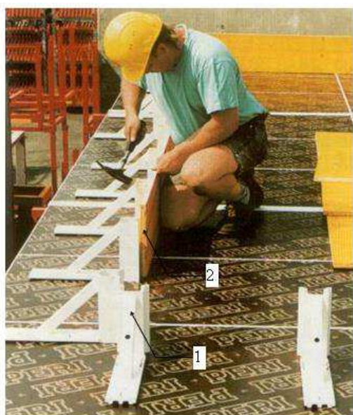
Рисунок 5.11 - Установка отсекателей: 1-кронштейн отсекателя; 2-палуба отсекателя
