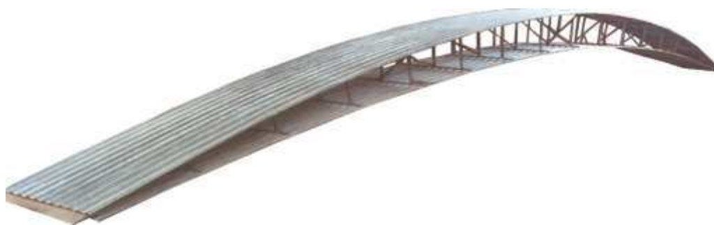
Рисунок 1.6 – Пространственное перенапряжённое двухпоясное арочное покрытие
