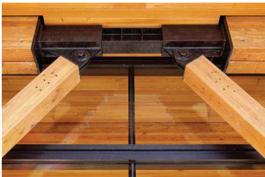
Рисунок 1.2.1 - Стальные пластины и нагели
