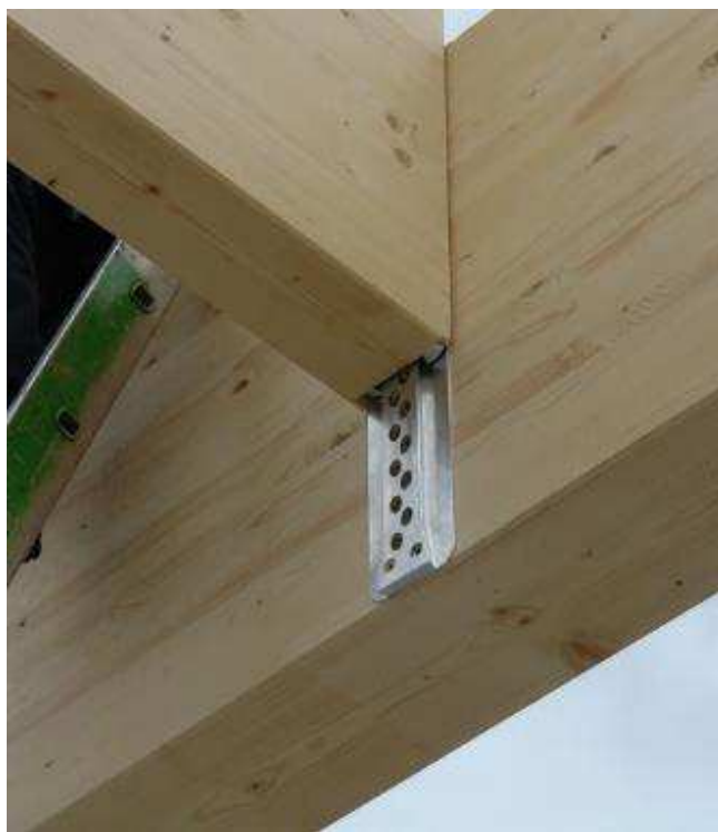
Рисунок 1.2.4 – Соединение «Ласточкин хвост»
