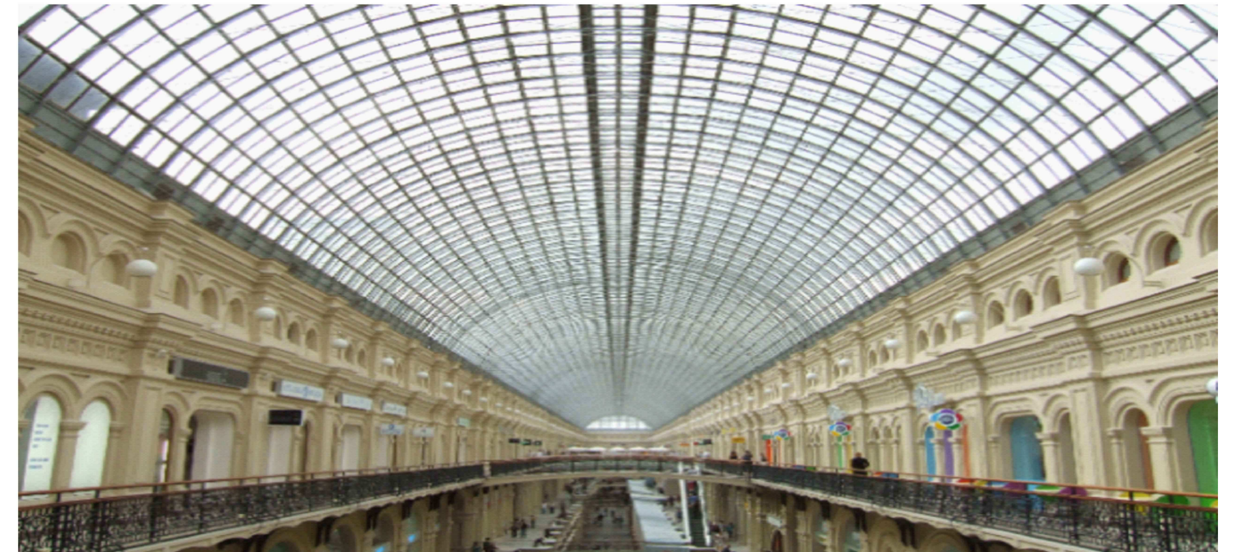
Усиление арок покрытия предварительно натянутыми струнами государственного универсального магазина в Москве (В. Г. Шухов)
