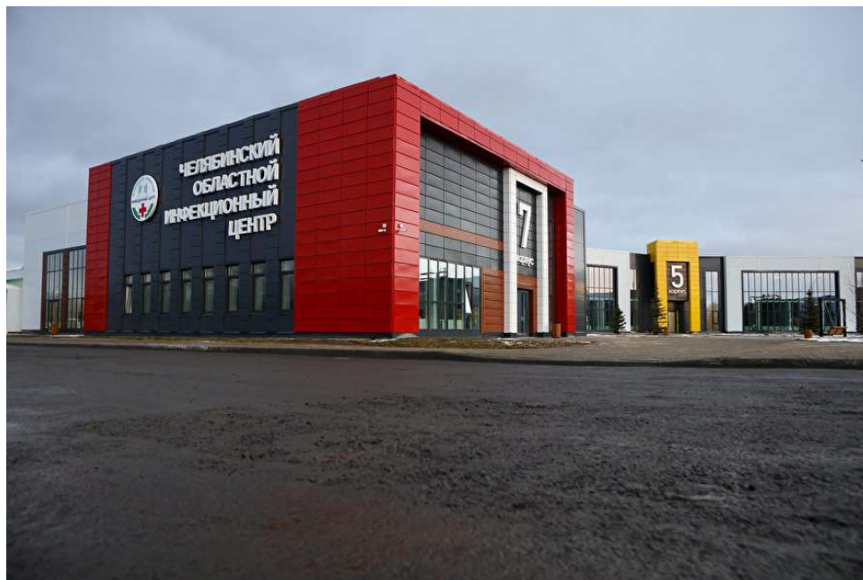
Рисунок 1.2 – Челябинский областной инфекционный центр
