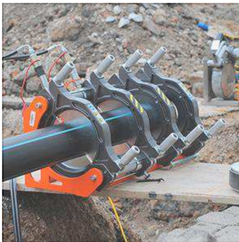
Рисунок 3 - Стыковая сварка
