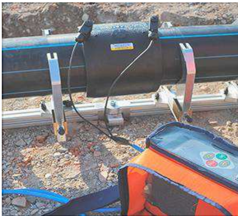
Рисунок 4 - Электромuftовая сварка
