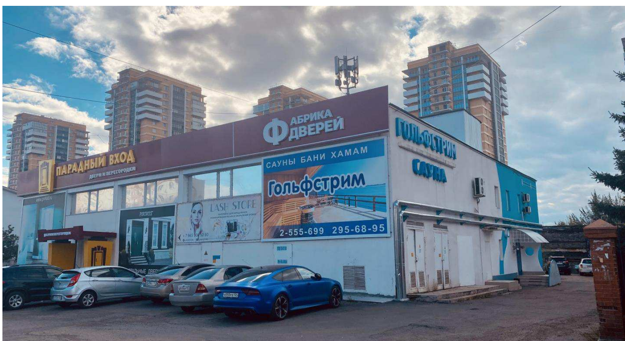
Рисунок 1 – Внешний вид здания
