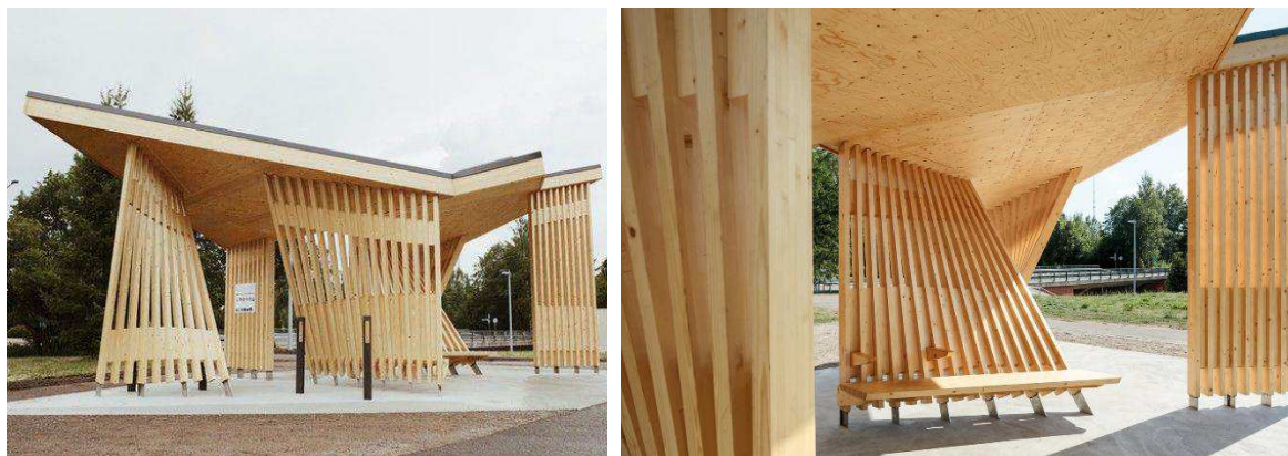
Рисунок 20 - Теневой навес для железнодорожной станции «Kohta», Финляндия
