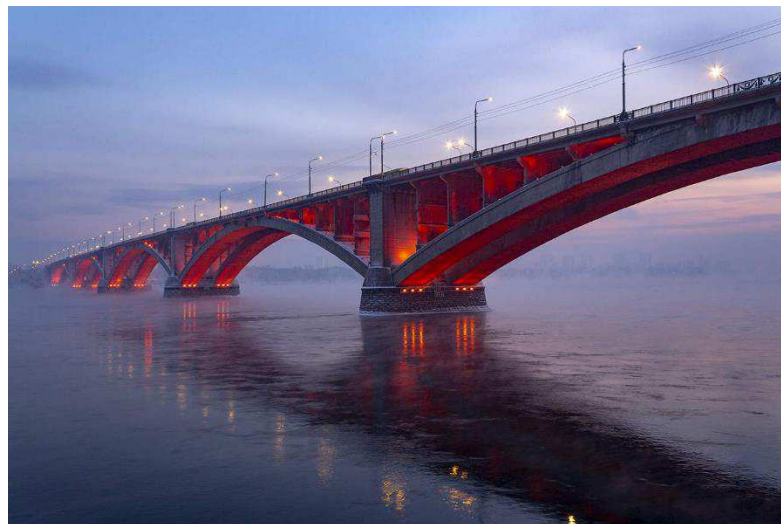
Рисунок 35 – Коммунальный мост, г. Красноярск
