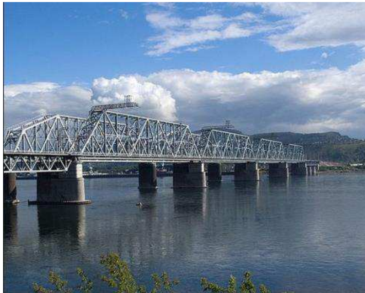
Рисунок 34 – Железнодорожный мост, г. Красноярск
