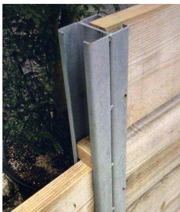
Рисунок 54 – Пример крепления реек в с-образном профиле
