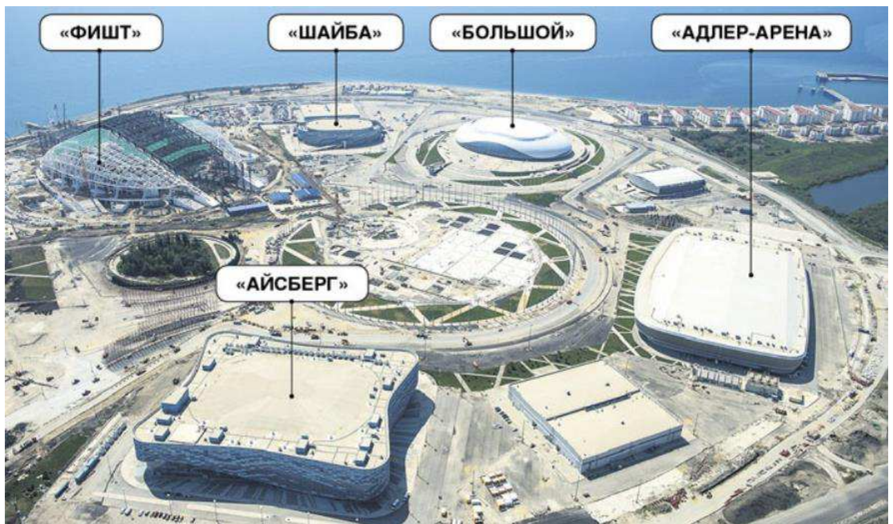
Рисунок 3 – Спортивные сооружения в г. Сочи
