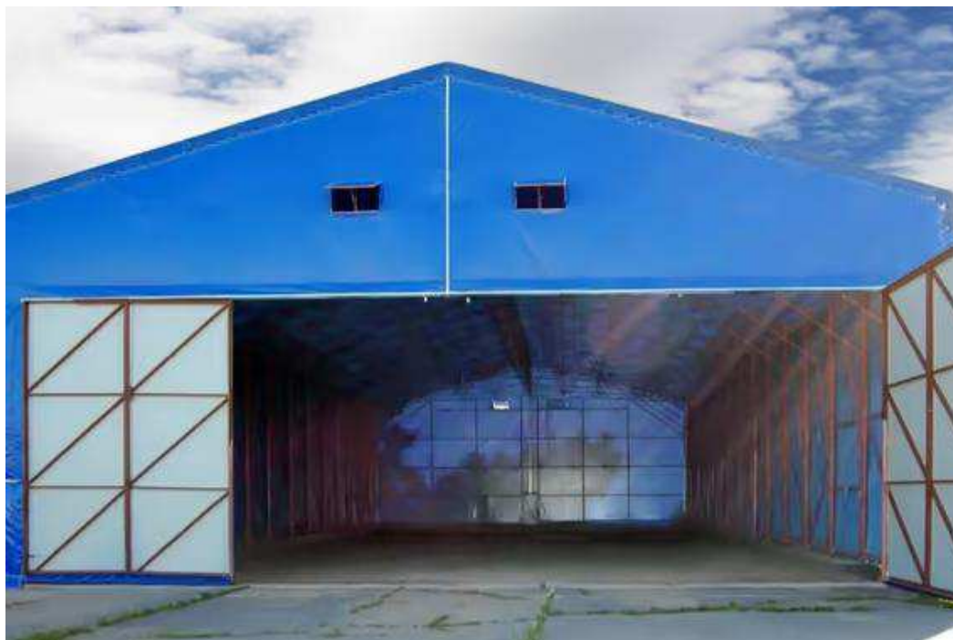
Рисунок 5- Каркасный тентовый ангар
