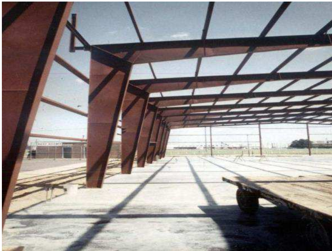
Рисунок 7- Ангар со стальным каркасом из двутавров
