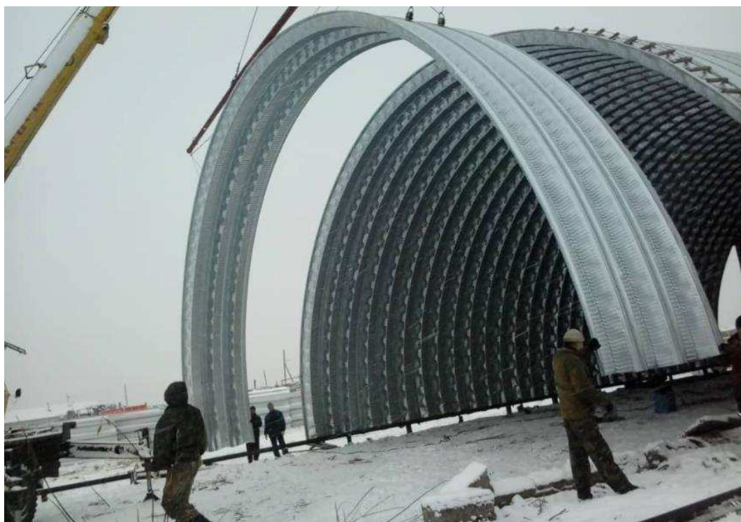
Рисунок 3- Бескаркасный неразборный ангар
