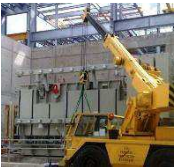
Рисунок 10 – монтаж силового трансформатора
