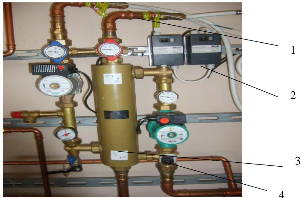
Рисунок 3.4 – Модуль разделитель систем Wilo-Safe:
