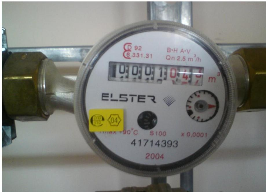
Рисунок 3.9 – Расходомер ELSTER (водосчетчик)
