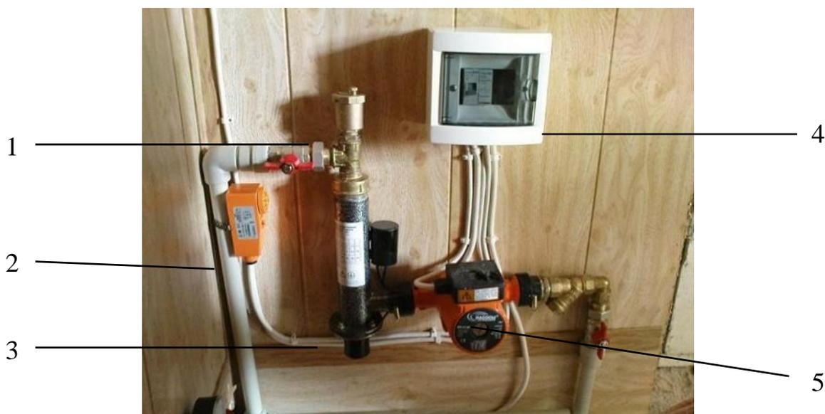
Рисунок 1.11 – Установка циркуляционного насоса:
